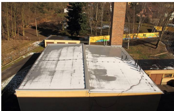
Oprava střechy na výměňkové stanici Křížatecká 16
