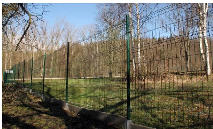
Oprava oplocení Křížatecká 16
