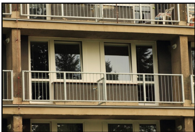
Investiční akce rekonstrukce balkonů
