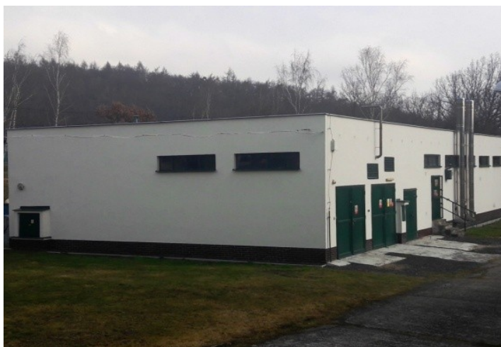
Rekonstrukce fasády a střechy na výměňkové stanici
