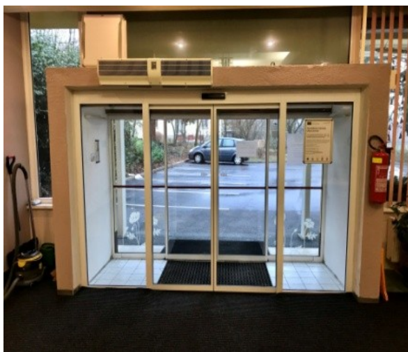
Oprava automatických vstupních dveří
