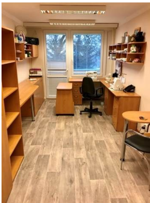
Výměna PVC v šijovně
