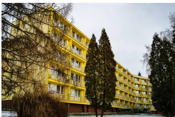
Zateplení budovy Křížatecká 16
